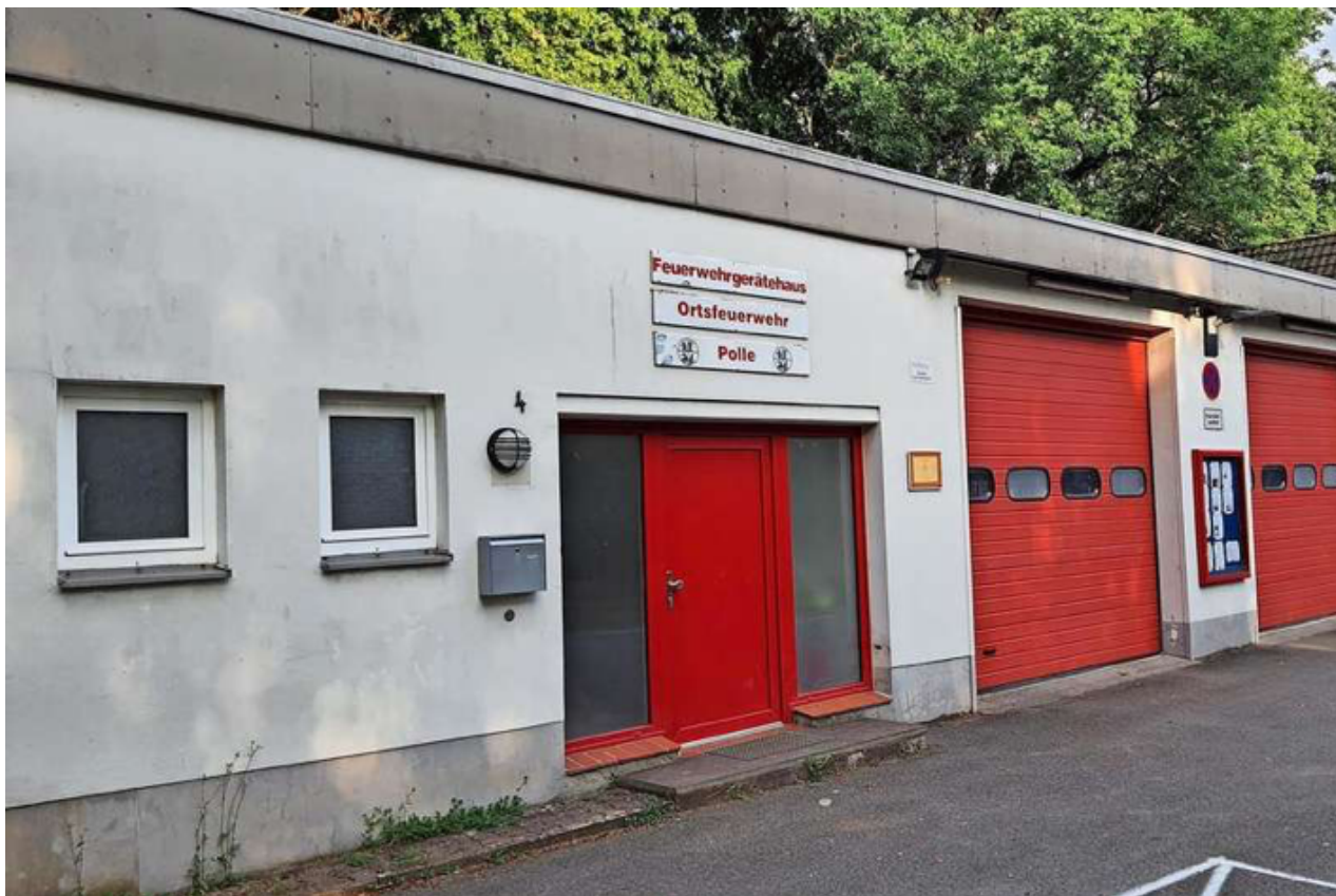
Gebäude aus den 1970er Jahren: Das Poller Feuerwengerätehaus entspricht nicht mehr den aktuellen Standards. Christian Albroscheit
